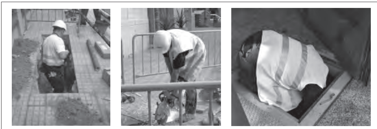
Figura. 3. Trabajo en zanjas pequeñas
