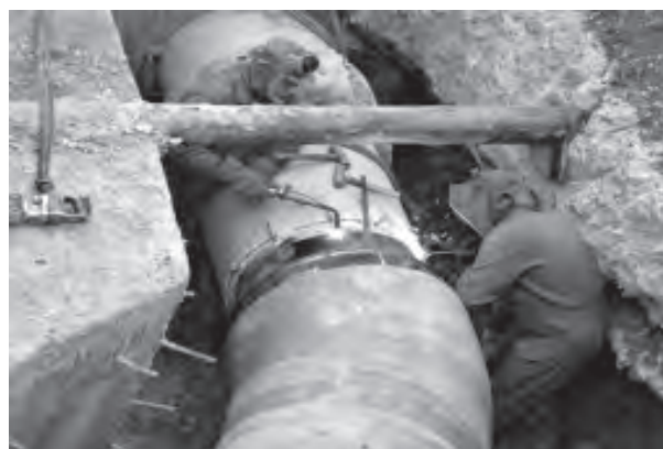
Figura 1. Trabajo en zanjas grandes
