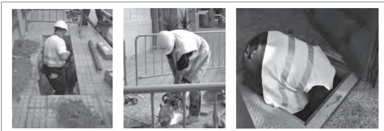
Figura. 3. Trabajo en zanjas pequeñas
